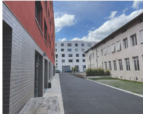
Amorce de la future connexion avec la rue du Tunnel
