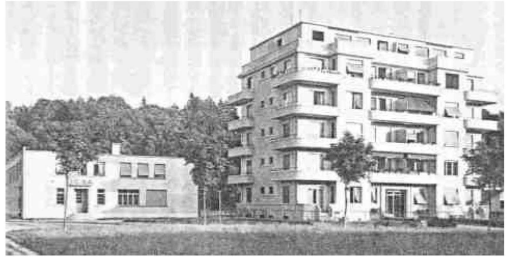
Photo des immeubles A-Tzala et B-Eskenazi en 1967.
