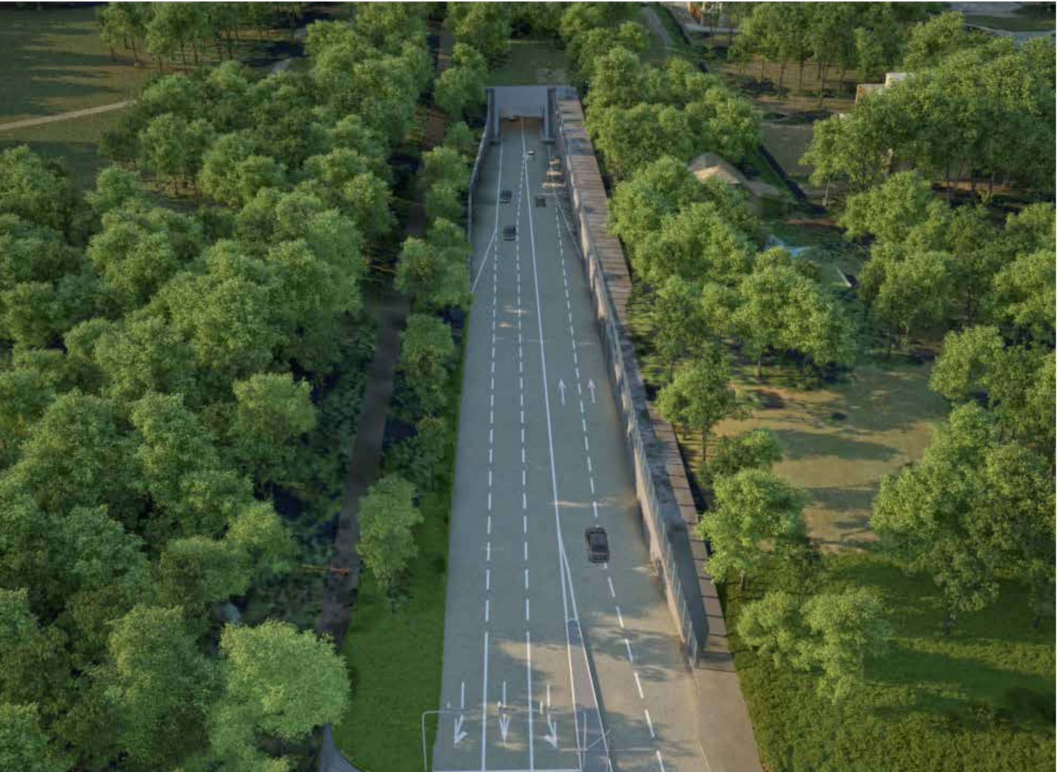
Entrée du tunnel avenue Appia
