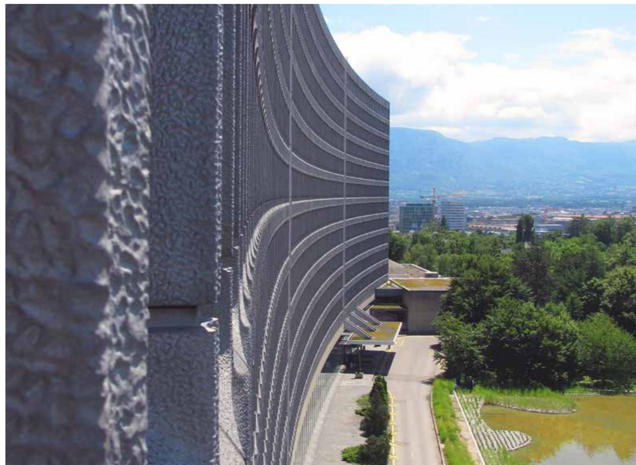
OIT : Rénovation complète du siège / Coût du projet : 300 mios CHF Réalisation : 2015-2019 / © OIT
