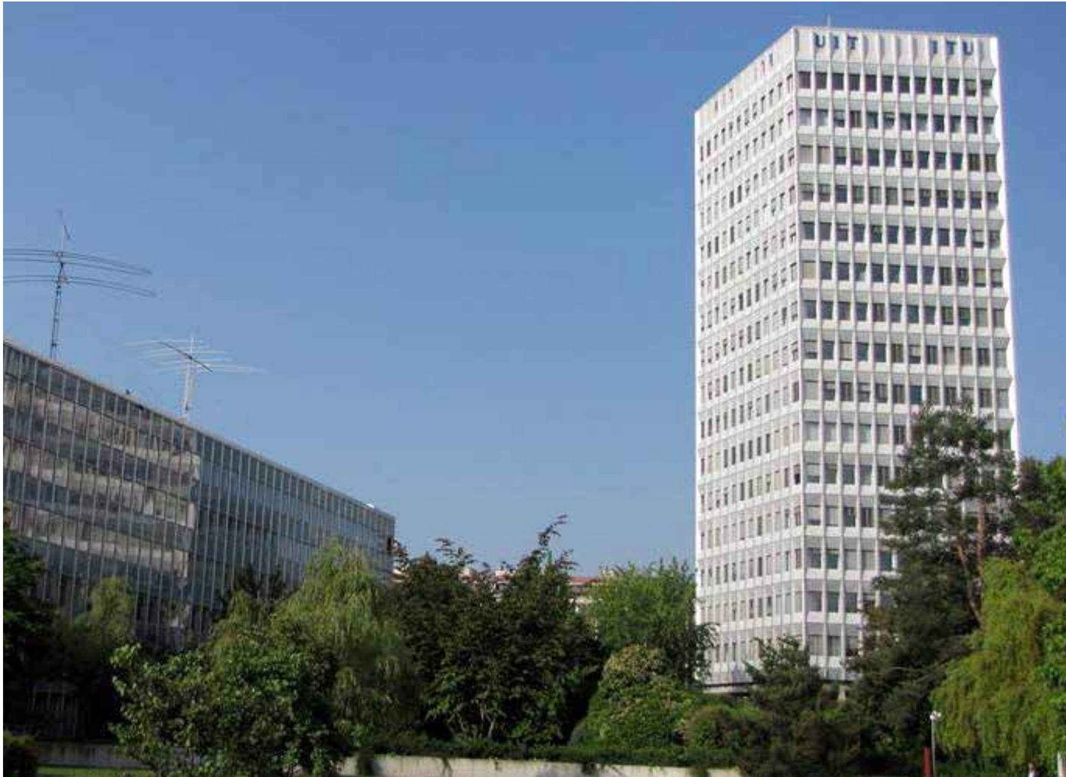
UIT : Construction d'un nouveau bâtiment / Coût du projet : 150 mio CHF Réalisation : dès 2020 / © UIT
