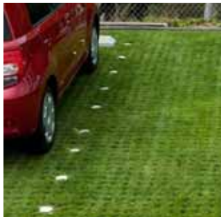
Grille-gazon sur les places de stationnement
