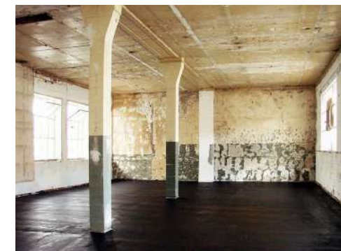
↑ Intérieur du bâtiment G de la SIP avant rénovation, © D. Page
